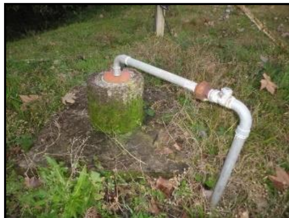
Figura 35. Detalhe do poço.
