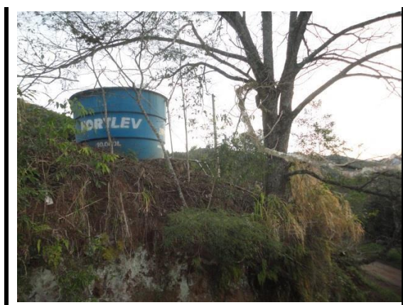
Figura 36. Reservatório de água de um dos SACs. Fonte: BSW, 2014.
