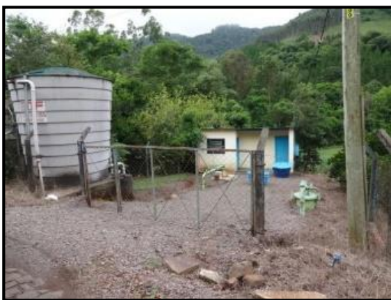
Figura 23. Localização do reservatório apoiado de 20m 3 junto ao ponto de captação.
