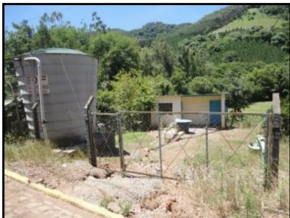
Figura 14. Vista da localização do poço do SAA.
