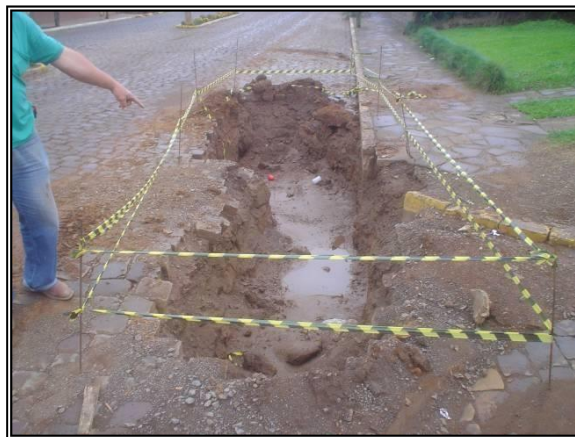
Figura 71. Local onde foi providenciada a troca e manutenção da tubulação.
