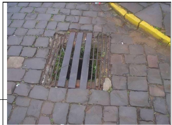
Figura 69. Sarjetas e bocas de lobo observadas nas vias urbanas.
