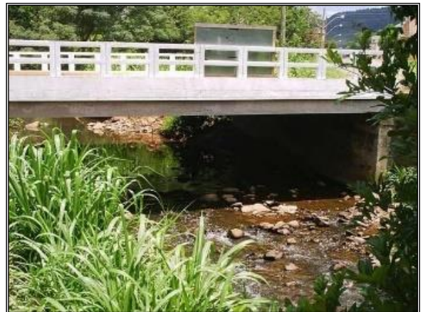
Figura 79. Ponte existente sobre o Arroio Putinga na zona urbana.
