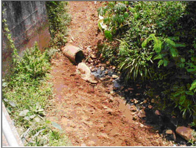
Figura 75. Conexão da tubulação de macrodrenagem em um pequeno Córrego, com evidências de ligações clandestinas de esgoto doméstico.
