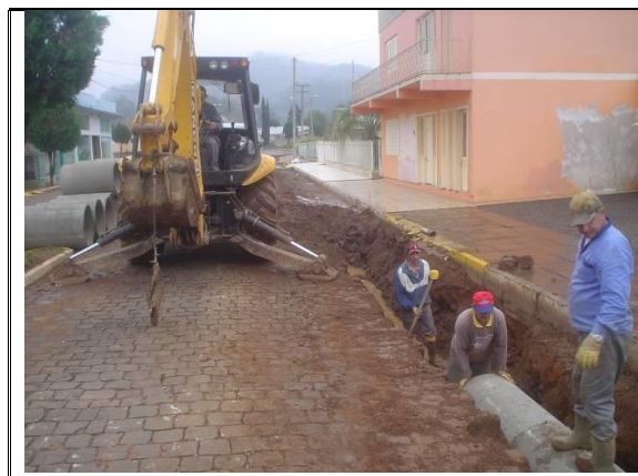
Figura 73. Manutenção do sistema de microdrenagem
