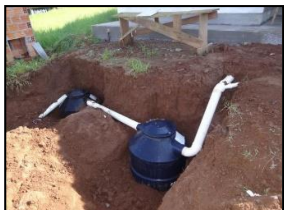
Figura 41. Fossa e filtro anaeróbio instalados em obra residencial.
