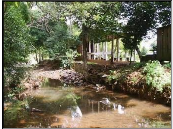
Figura 77. Muro construído na margem do Arroio Putinga.
