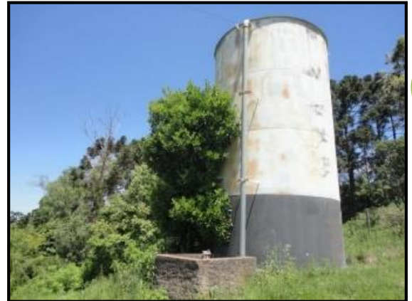
Figura 26. Reservatório apoiado de 50m 3 .
