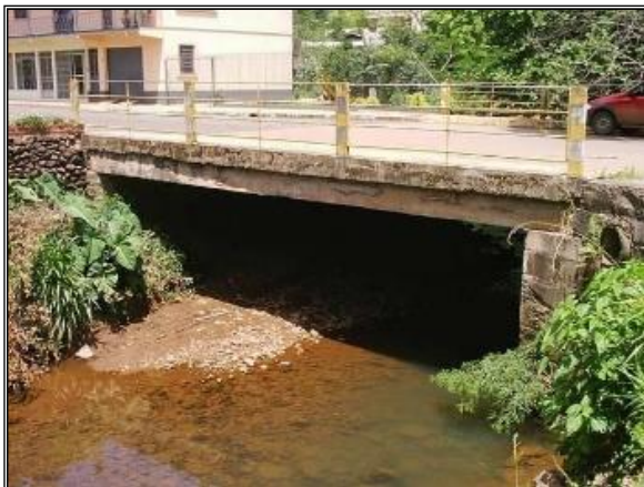
Figura 78. Ponte existente sobre o Arroio Putinga na zona urbana.
