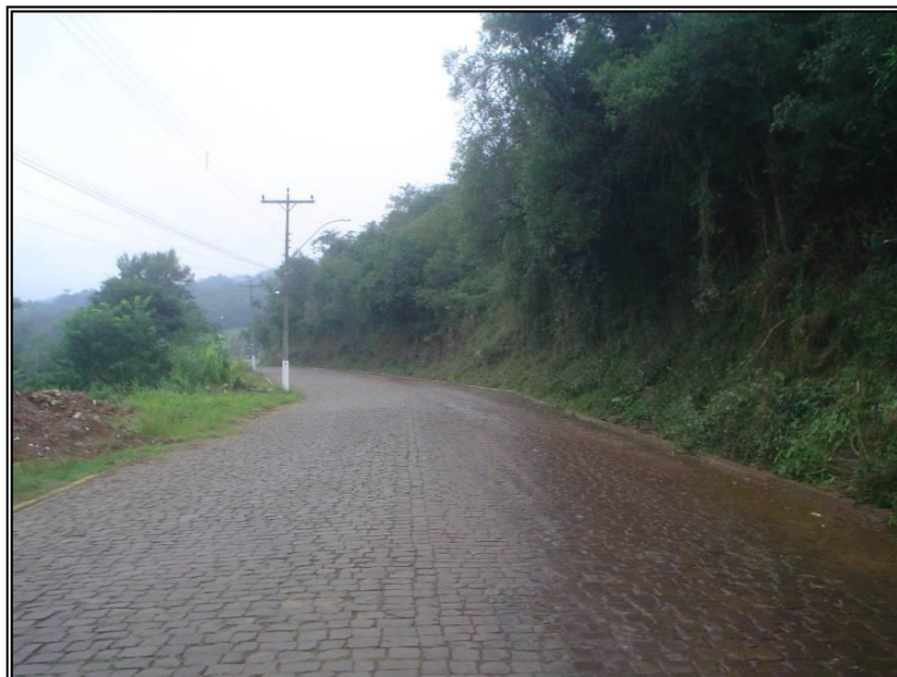
Figura 74. Exemplo de rua existente na sede municipal que não apresenta sistema de microdrenagem (Rua Julio de Castilhos).
