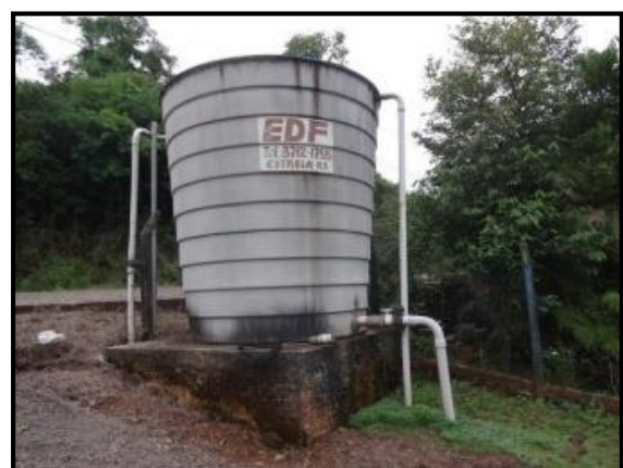
Figura 24. Reservatório apoiado de 20m 3 .
