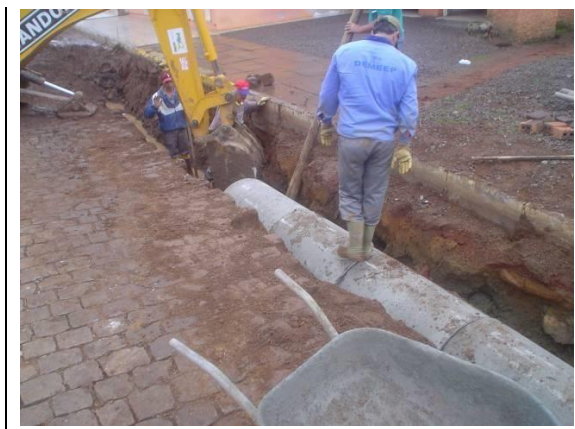
Figura 72. Manutenção do sistema de microdrenagem
