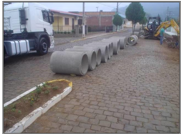
Figura 67. Tubulação de concreto implantada na manutenção do sistema de microdrenagem.
