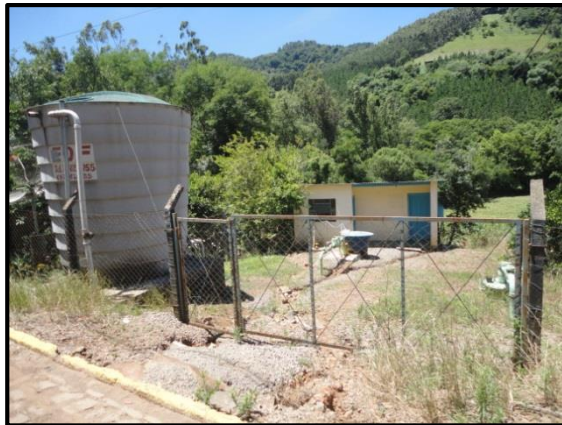
Figura 14. Vista da localização do poço do SAA..
