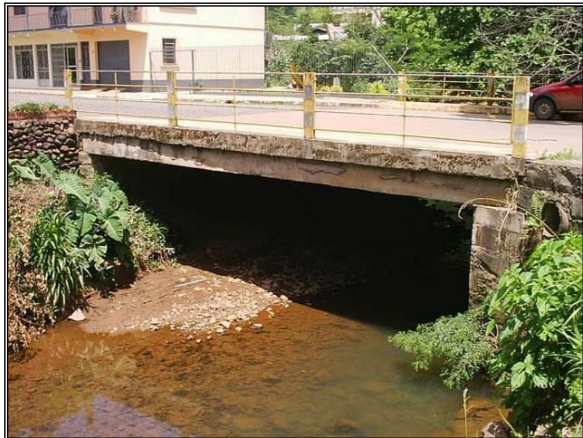
Figura 82. Ponte existente sobre o Arroio Putinga na zona urbana.
