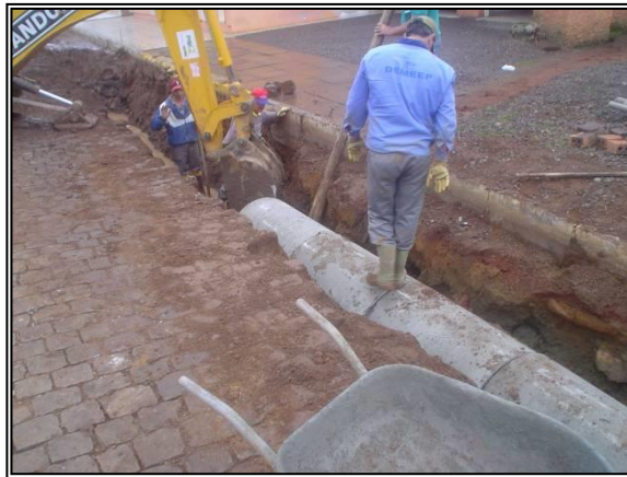
Figura 76. Manutenção do sistema de microdrenagem.
