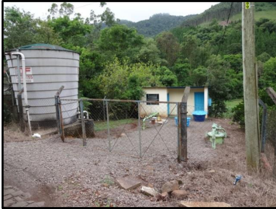
Figura 23. Localização do reservatório apoiado de 20m 3 junto ao ponto de captação..
