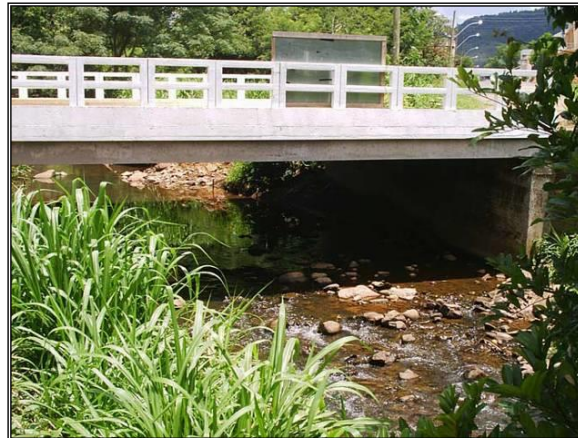
Figura 83. Ponte existente sobre o Arroio Putinga na zona urbana.
