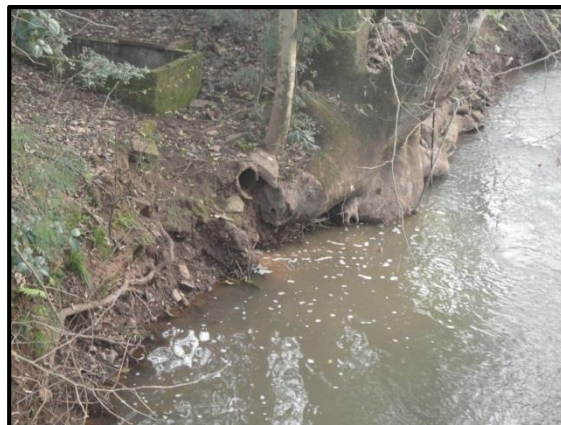
Figura 45. Lançamento de efluente no Arroio Putinga.
