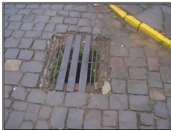
Figura 73. Sarjetas e bocas de lobo observadas nas vias urbanas.
