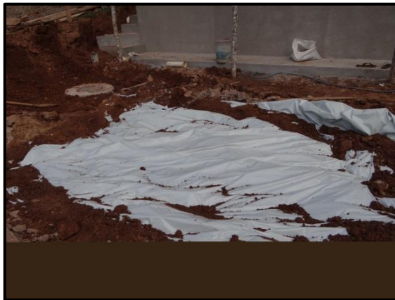
Figura 42. Sumidouro construído para receber o efluente oriundo de sistema de fossa e filtro.
