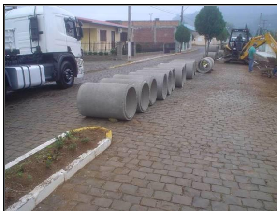
Figura 71. Tubulação de concreto implantada na manutenção do sistema de microdrenagem.
