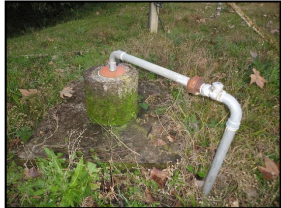
Figura 35. Detalhe do poço.
