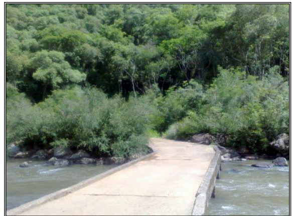
Figura 87. Ponte sobre Rio Forqueta - Divisa com Fontoura Xavier
