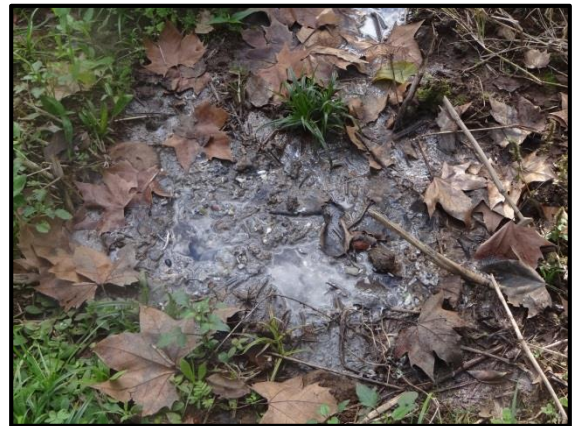
Figura 43. Lançamento de esgoto in natura no solo (a céu aberto).
