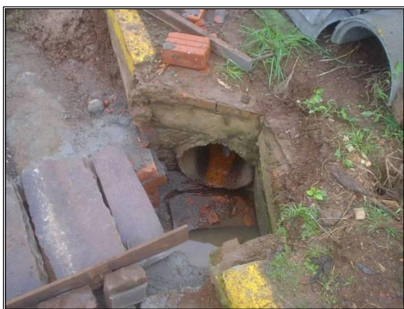
Figura 70. Tubulações de concreto existente no sistema de microdrenagem.
