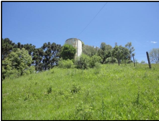
Figura 25. Vista da localização do reservatório de 50m 3 .
