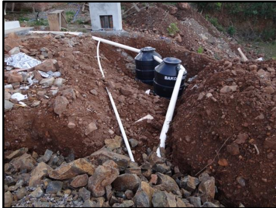
Figura 40. Conjunto de fossa e filtro anaeróbio instalados em obra residencial.
