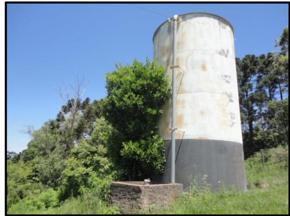
Figura 26. Reservatório apoiado de 50m 3 .
