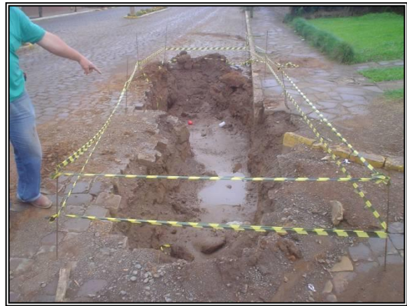
Figura 75. Local onde foi providenciada a troca e manutenção da tubulação.
