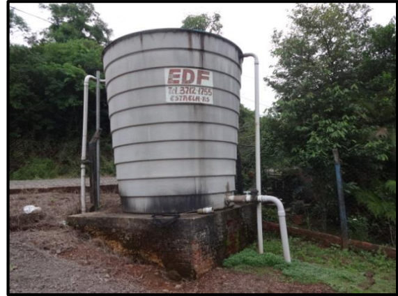
Figura 24. Reservatório apoiado de 20m 3 .
