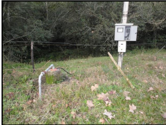
Figura 34. Vista geral do poço de um dos SACs.
