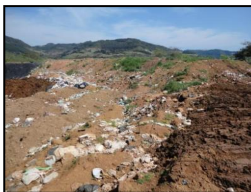
Figura 54. Vista dos resíduos depositados na célula do aterro e cobertos com solo.
