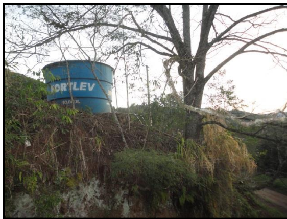
Figura 36. Reservatório de água de um dos SACs. Fonte: BSW, 2014.
