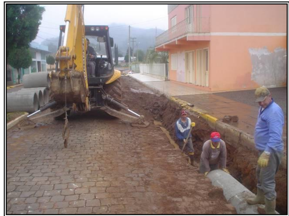
Figura 77. Manutenção do sistema de microdrenagem
