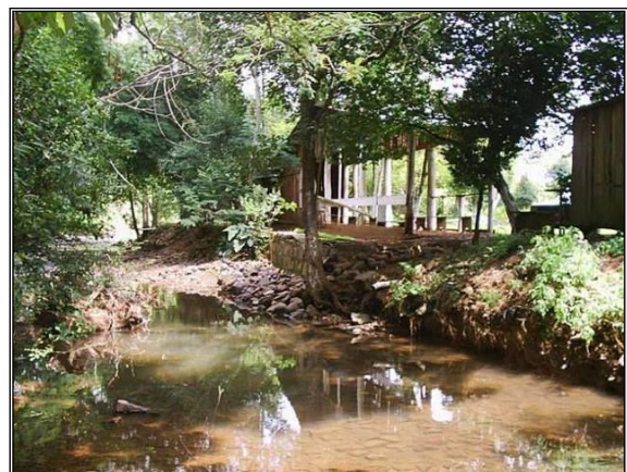
Figura 81. Muro construído na margem do Arroio Putinga.
