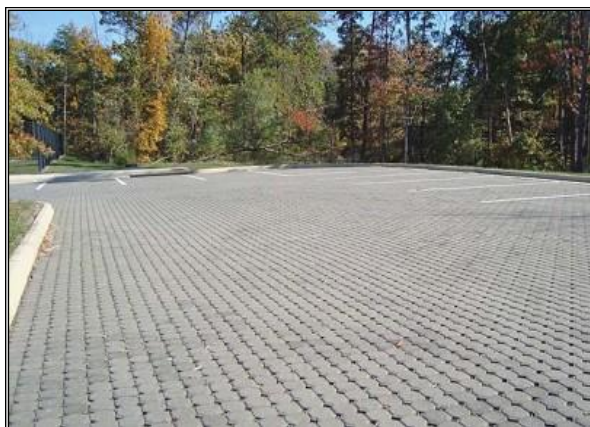
Figura 91. Blocos de concreto.
